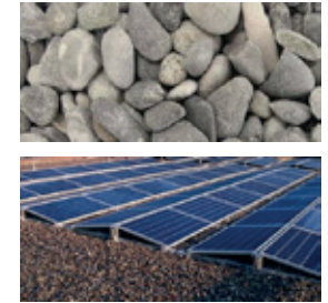
Flachdach Rundkies 8/16, PV-Anlage im Modulsystem auf Flachdach (Contracting-Modell)
