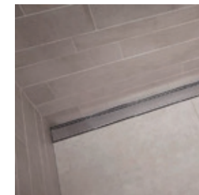
Dusche Boden Feinsteinzeug im Gefälle mit integrierter Rinne z.B. Typ Cleanline Fa. Geberit Duschtrennwände in Klarglas
