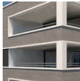
Balkongeländer Horizontale Traversen in Metall, gem. Plan Architekt, einbrennlackiert, RAL 7022, umbragrau
