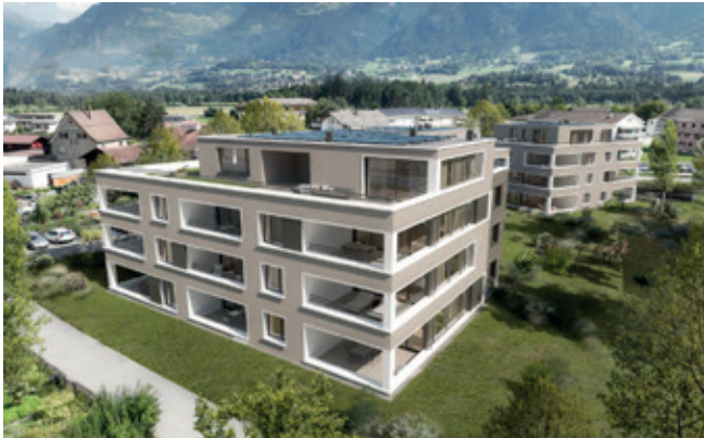
Holzassade Hinterlüftete Holzassade, offen Fichte/Tanne, sägeroh, Lasur ArboGrey Mica 600 Horizontalschalung
