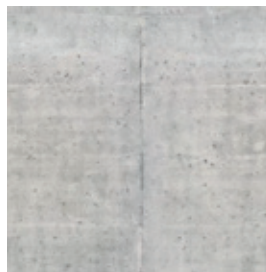
Wände und Decken Beton roh
