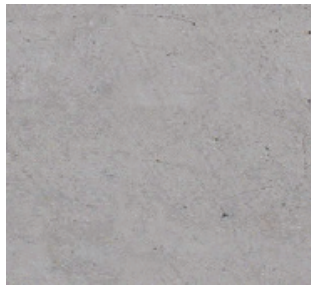
Boden Zementüberzug gestrichen
