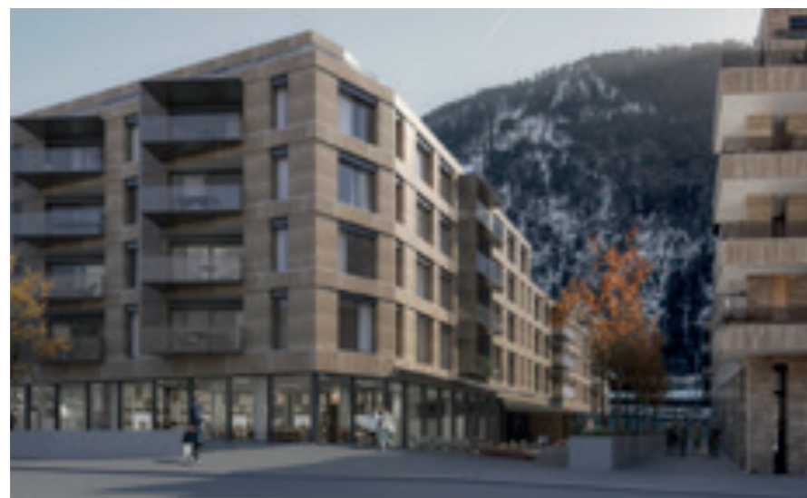
Hauptfassade Aussenwärmesystem aus Mineralwolle und Natursteinvorsatz (Travertin) sämtliche Untersichten verputzt bzw. gestrichen, weiss
