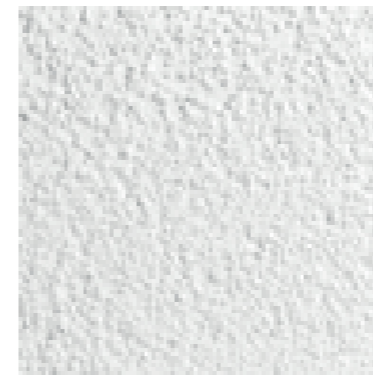
Wände Treppenhaus Fertigputz 1 mm abgerieben NCS S 0500-N, weiss
