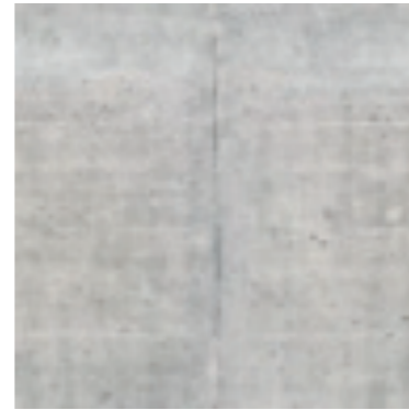
Wände und Decken Beton roh
