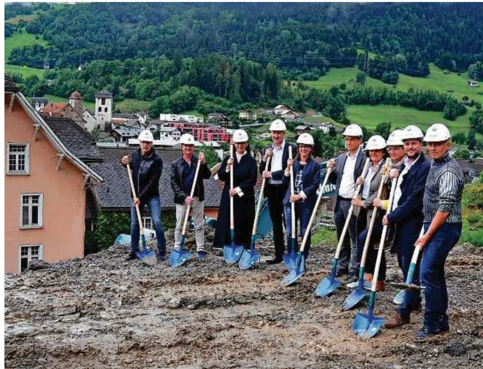
Alle packen mit an: Am Spatenstich des Neubaus der «Residenza St. Joseph» in Ilanz/Glion tragen die Projektbeteiligten schon einmal die erste Schicht Schlamm ab. Bild Andri Nay
